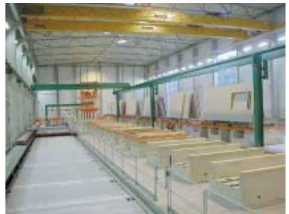
Bild 5. Entschalbereich für Elementdecken und Wandelemente Skandinaviska Byggelement AB, S-Katrineholm Fig. 5. Demolding area for precast floor and wall units at Skandinaviska Byggelement AB, S-Katrineholm
