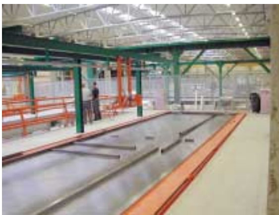
Bild 3. Arbeitsbereich Schalungsergänzung Skandinaviska Byggelement AB, S-Katrineholm Fig. 3. In this work area at Skandinaviska Byggelement AB, S-Katrineholm, the formwork is completed
