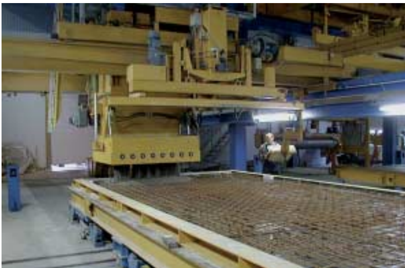
Abb. 3. Betonierbereich Fig. 3. Concreting area
