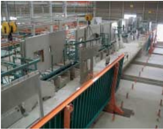
Abb. 5. Entschalbereich Fig. 5. Area for removing formwork
