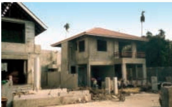
Bild 3. Witterungsunempfindliche Bauweise mit Fertigteilen Fig. 3. Construction with precast components independent of the weather
