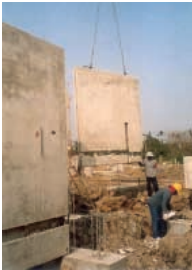
Bilder 4, 5. Geschlitzte Doppelwände, in die die Deckenplatte eingeführt wird. Die Wände werden direkt auf die Pfeilerfundamente gestellt Figs. 4, 5. Slotted double walls are inserted into the floor slab. The walls are mounted directly on the pier foundation
