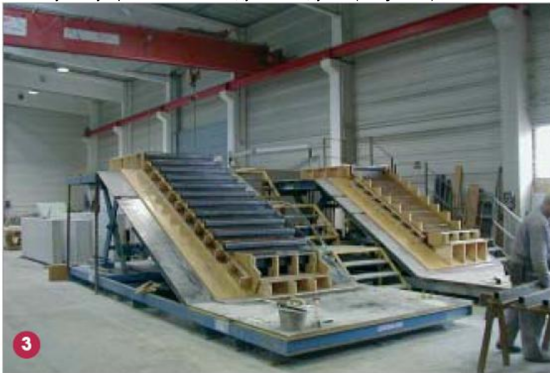
Пологий откос для опалубки, которая размещена на устройстве на воздушной подушке
