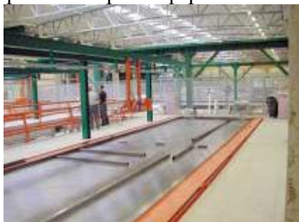
Рис. 3. Рабочая область. Дополнительная опалубка Скандинависка Буггэлемент АВ, S – Katrineholm.
