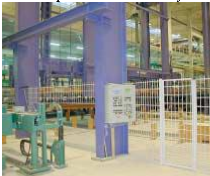
Рис.2 Защитные устройства на производственной установке.
