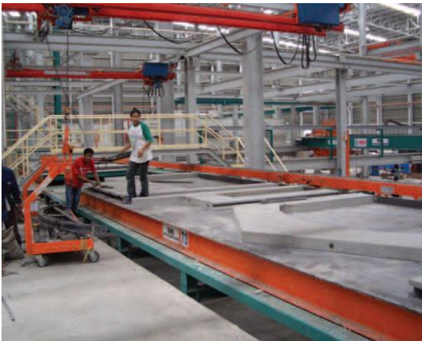
Снятие опалубочной формы
