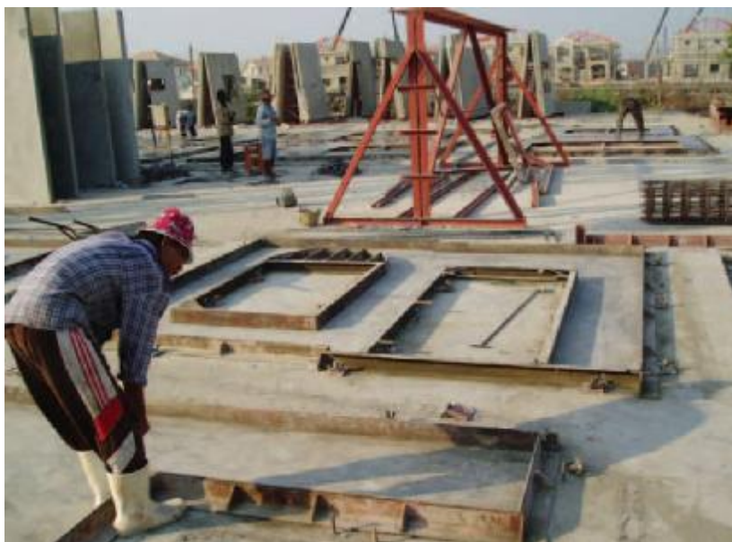
Площадка для изготовления сборных бетонных конструкций, завод Preuksa
