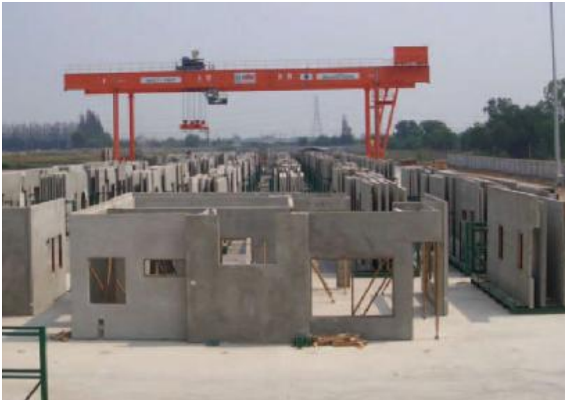
Портальный кран и участок складирования
