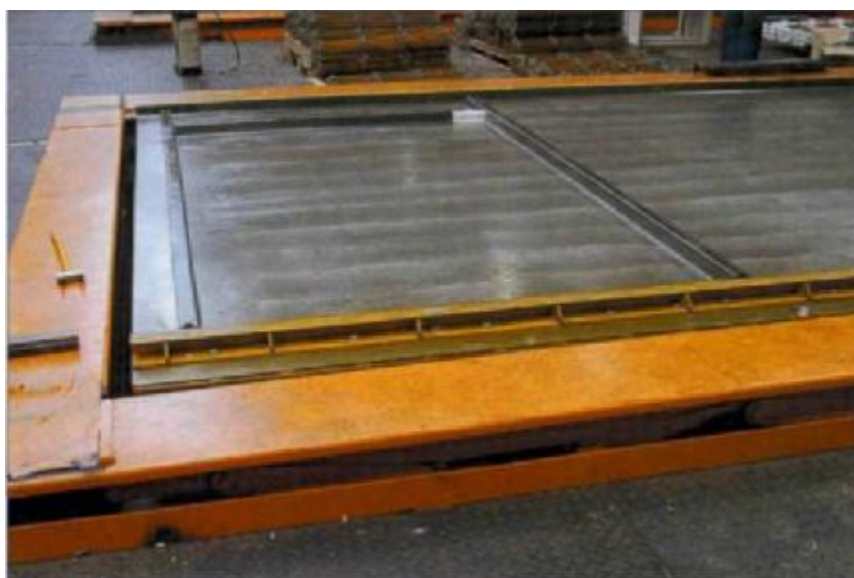
Паллет на этапе опалубки в зоне армирования.
