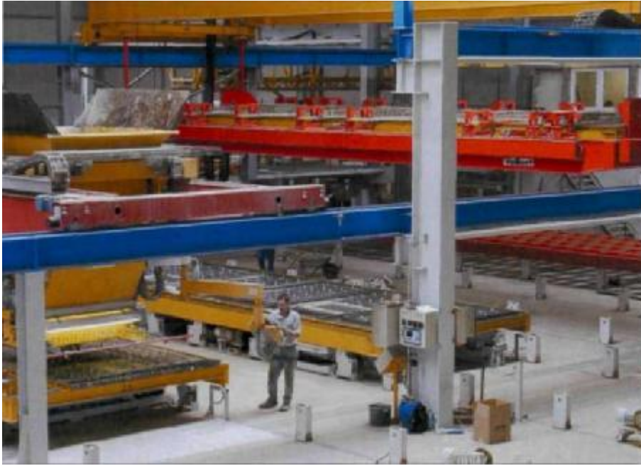
Бетонораспределитель и поворотный участок.
