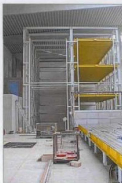
Камера подсушки во время этапа сборки
