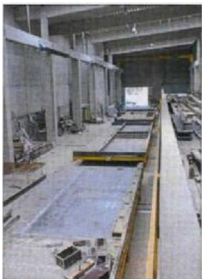
Установка для опалубки
