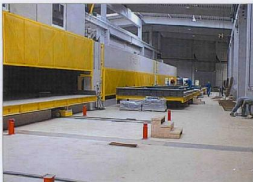
Центральный откатный мост погружного типа и армирующие установки
