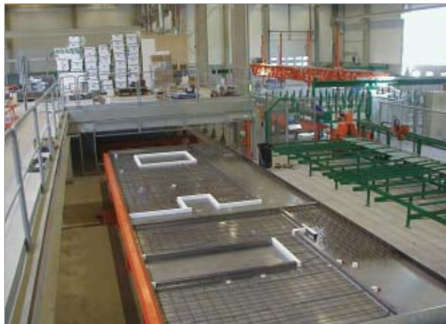
Die Verarbeitung der Gitterträger
