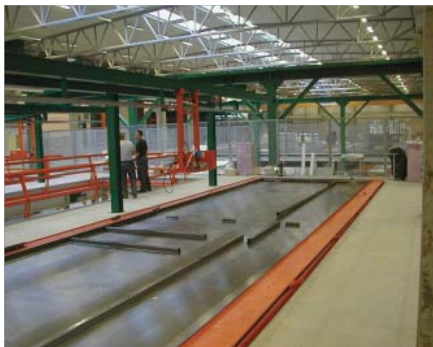
Die manuellen Schalplätze
