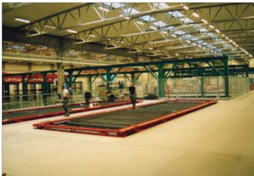
Ergänzung der Bewehrung
