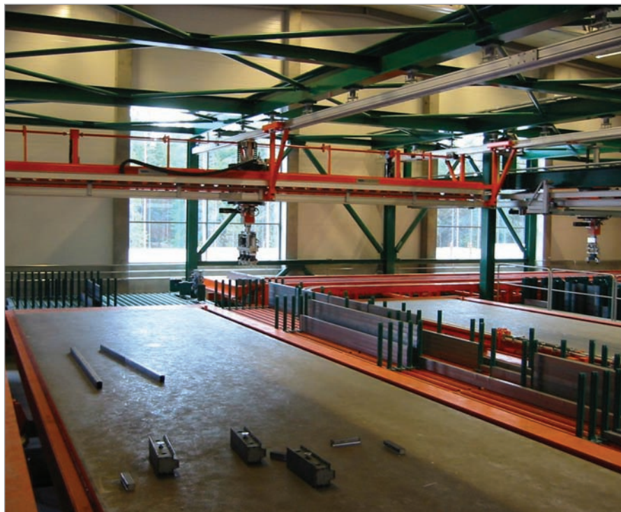
Schalungsroboter und Magazinroboter während der Inbetriebnahme
