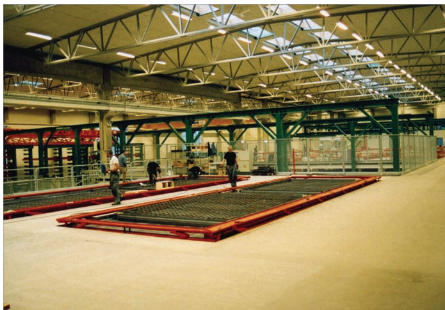
Ergänzung der Bewehrung
