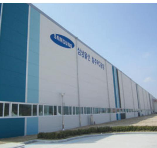
Fassade aus Spannbetonfertigteilelementen
