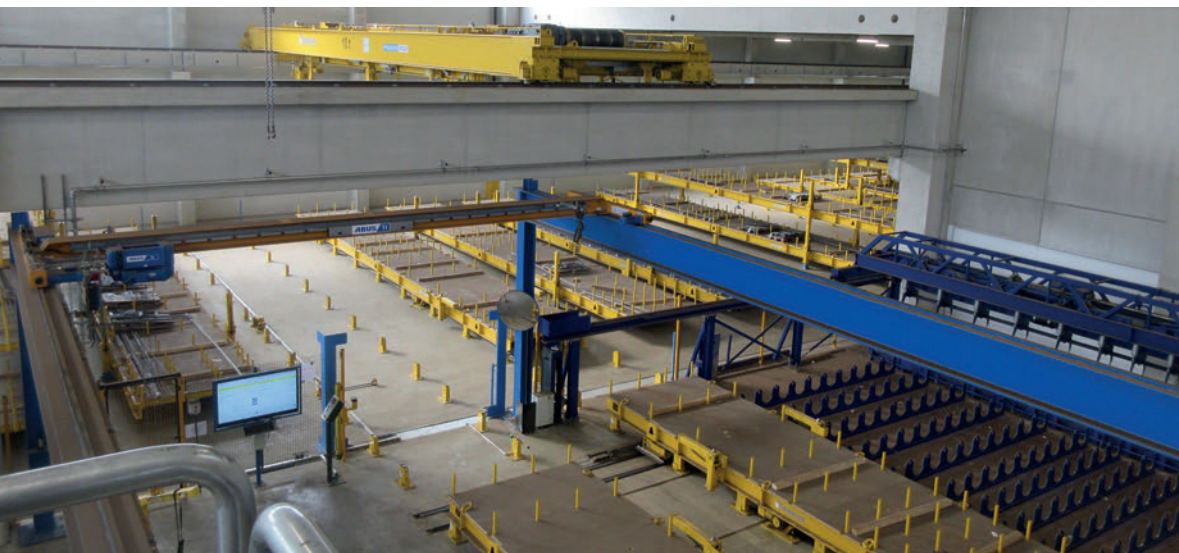
Beladen der Transportpaletten und Übergabe in den Automatikbereich
