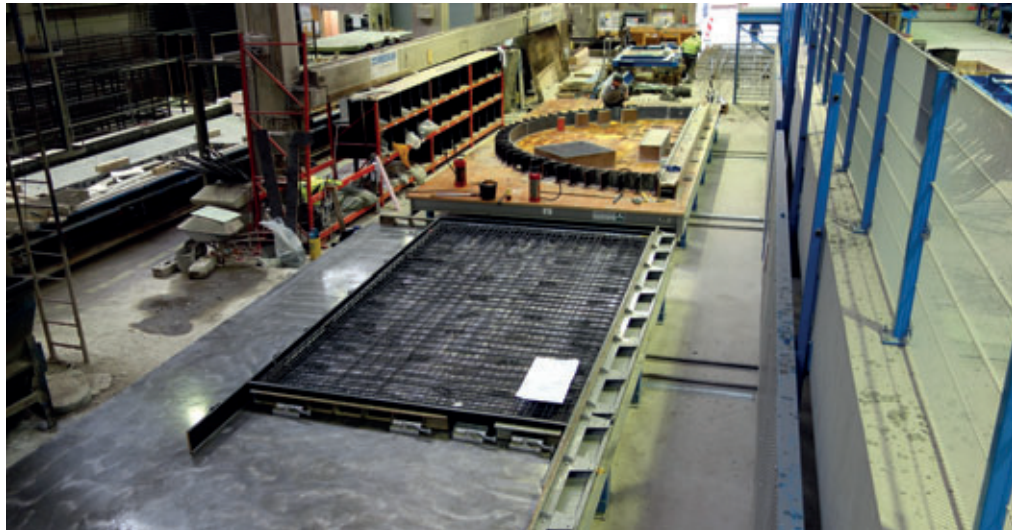
Fig. 5: Estaciones de encofrado y armadura para muros macizos/sándwich y elementos especiales
