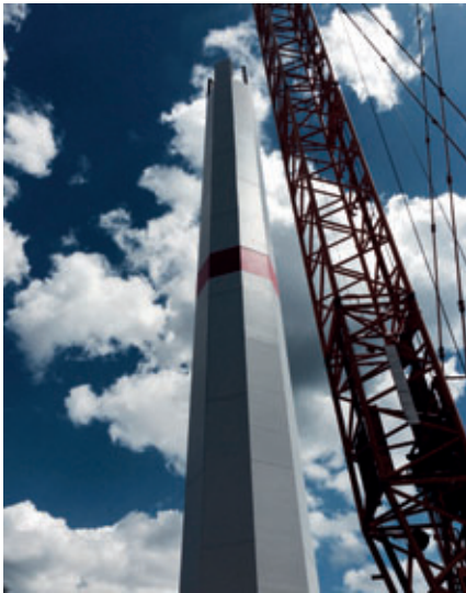
Fig. 1: Torre híbrida Ventur patentada para aerogeneradores
