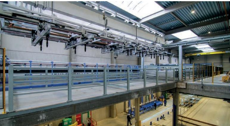
*Toda la preparación de refuerzo totalmente automatizada tiene lugar en un nivel intermedio superior*
