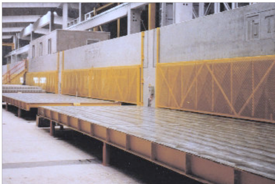
Arbeitsplätze Schalen und Bewehren
