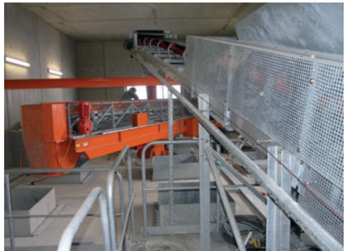
Los distribuidores rotativos debajo de las mezcladoras transportan el hormigón o bien al distribuidor de hormigón, a un camión hormigonera o a la tolva de limpieza de la instalación de reciclaje.
