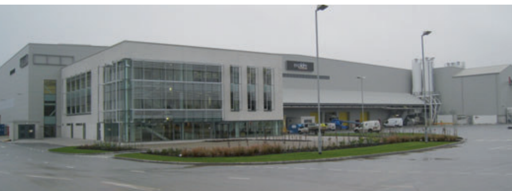
Fig. 1: Fábrica y edificio de oficinas
