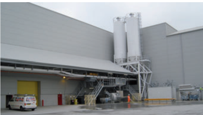
Fig. 37: Sistema de transporte de hormigón "Conflex" de Skako y planta de reciclaje de Bibko
