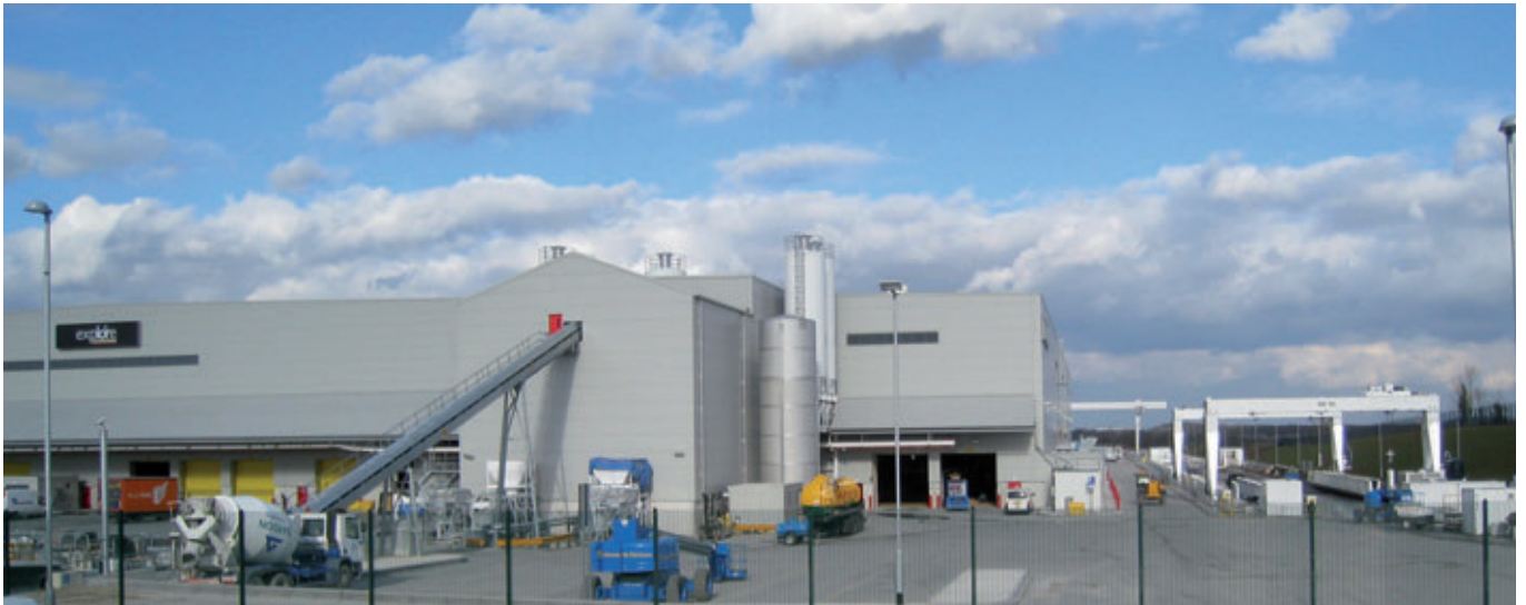
Fig. 4: Edificio de la fábrica con la planta de hormigón de Skako y el Civils Yard
