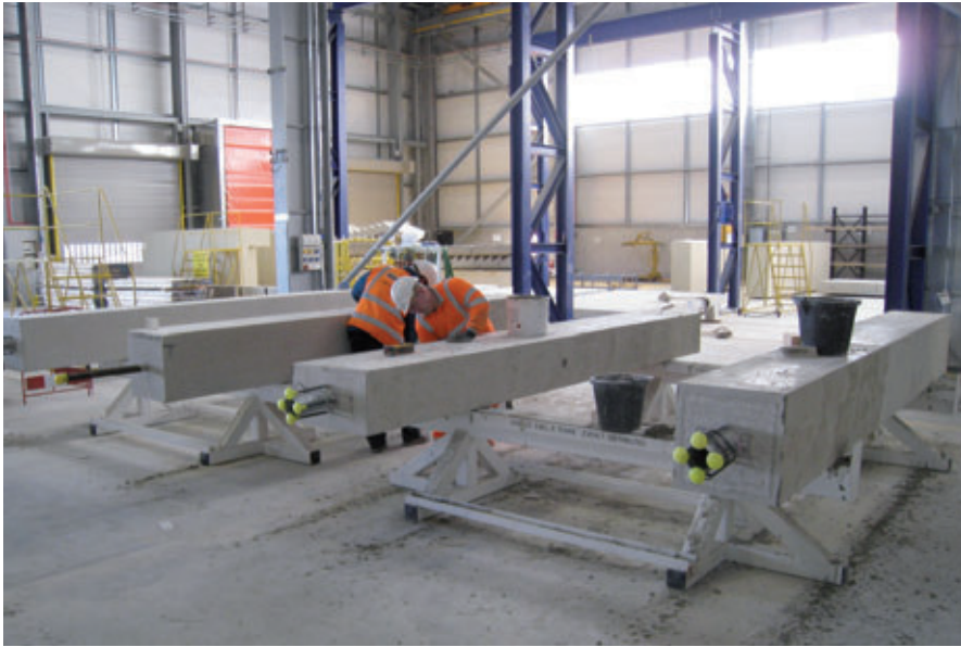
Fig. 22: Zona para los retoques y el acabado final
