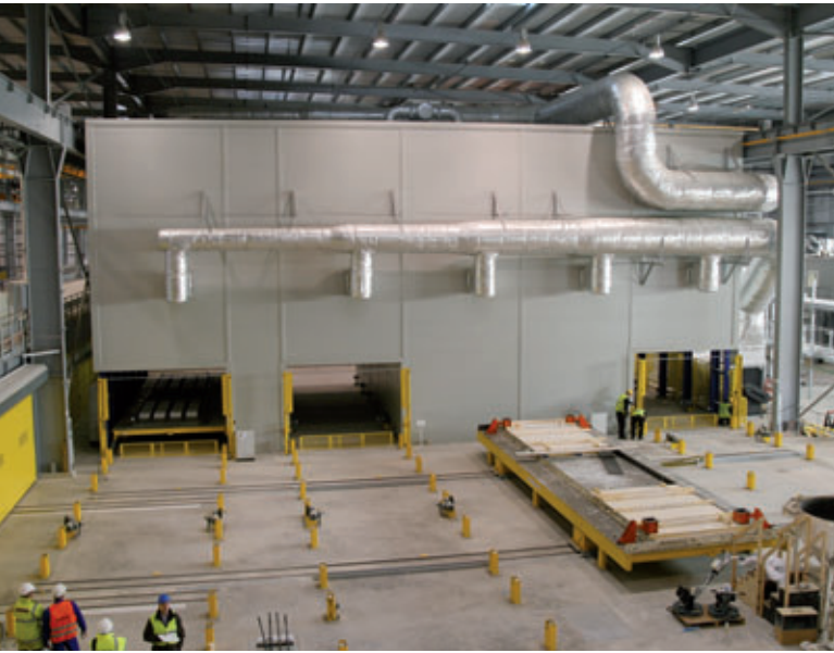
Fig. 20: Hormigonado y acabado, cámaras de curado
