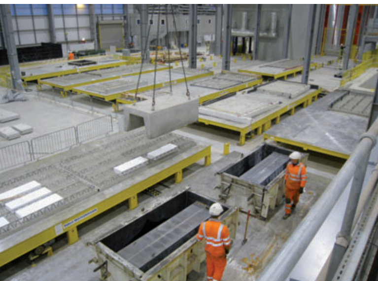
Fig. 17: Vista general 2 Circuito de carrusel para productos especiales "BSC"
