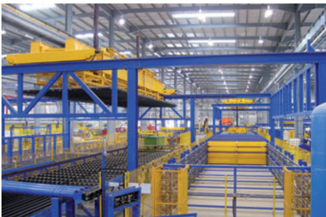
Fig. 30: Grúa para los mallazos y almacén auxiliar
