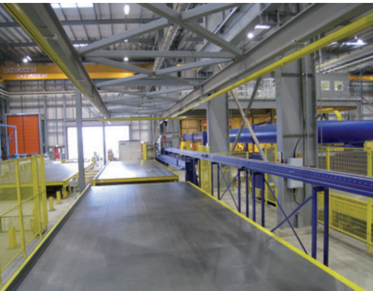
Fig. 16: Estación de recogida de encofrados
