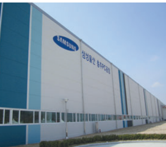
Fachada de elementos prefabricados de hormigón pretensado
