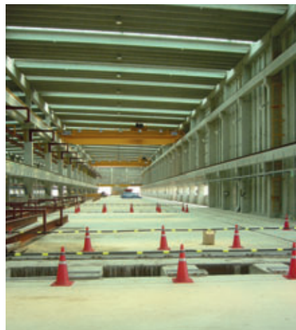
Nueva superficie para el incremento de la capacidad productiva de elementos prefabricados de hormigón pretensado en la fábrica PC2
