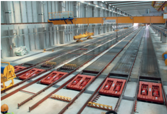
Instalación de producción de placas alveolares pretensadas
