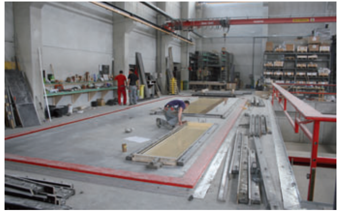
Sonderbauteile, wie sie Nägelebau in Auftragsfertigung herstellt, erfordern wegen der individuellen Formen einen hohen Grad an manueller Schalungsarbeit
