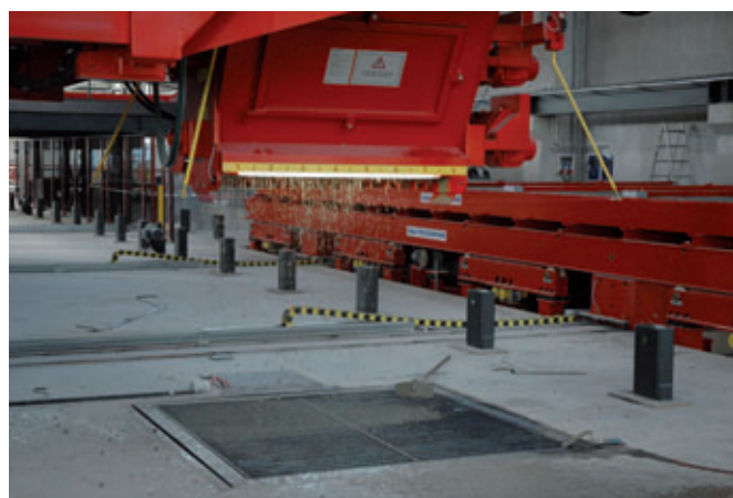
Integrierte Reinigungsstation direkt neben der Betonierstation
