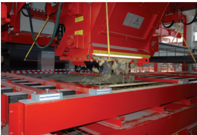
Der Betonverteiler ermöglicht ein genaues Befüllen der Schalung
