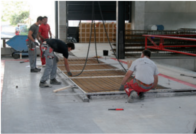
Einlegen der Bewehrung an der nächsten Arbeitsstation
