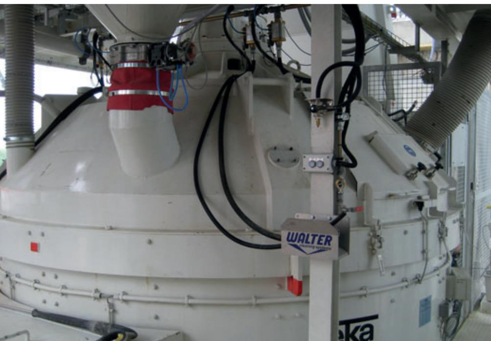
Plataforma de mezcladora con mezcladora planetaria de alto rendimiento TPZ 3750 de Teka
