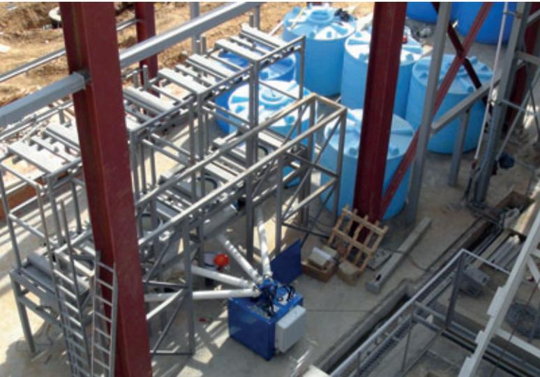
Sistema de dosificación de color completamente automática tipo TFW de Würschum durante el montaje
