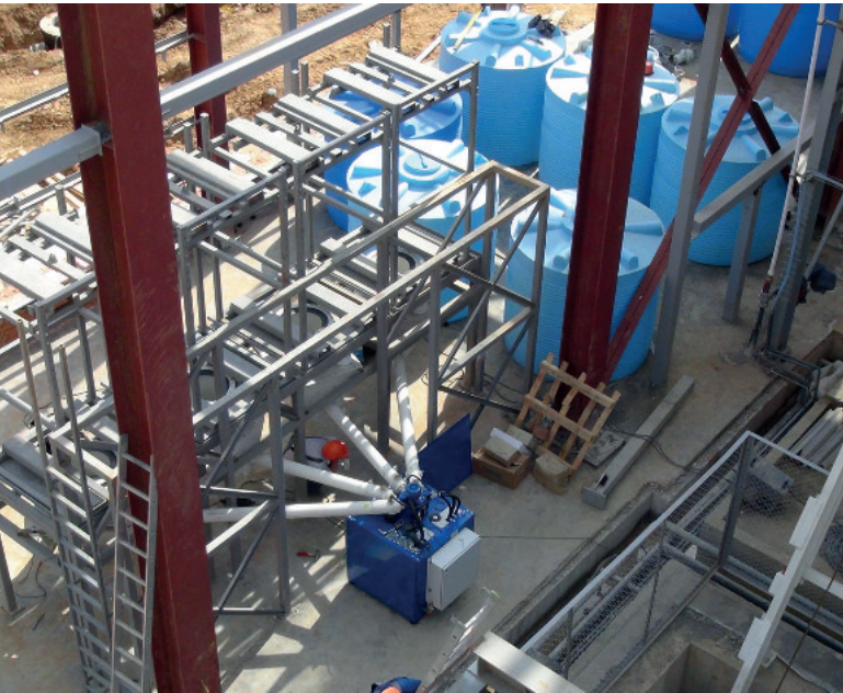
Полностью автоматизированный дозатор для пигментов TFW Wurschum во время монтажа
