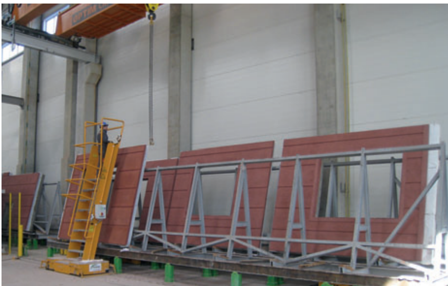
Entrega a la zona de acabado
