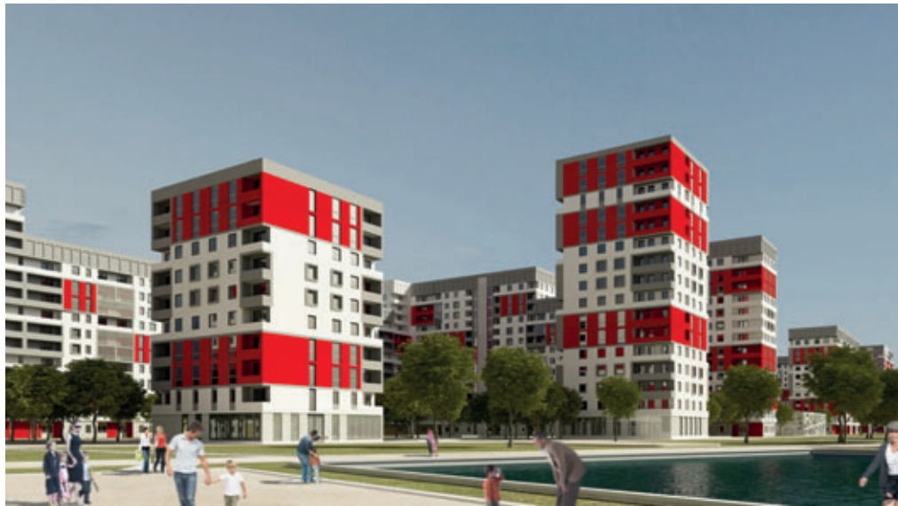
Ejemplo de la arquitectura de los edificios construidos con los elementos prefabricados de hormigón de Morton
