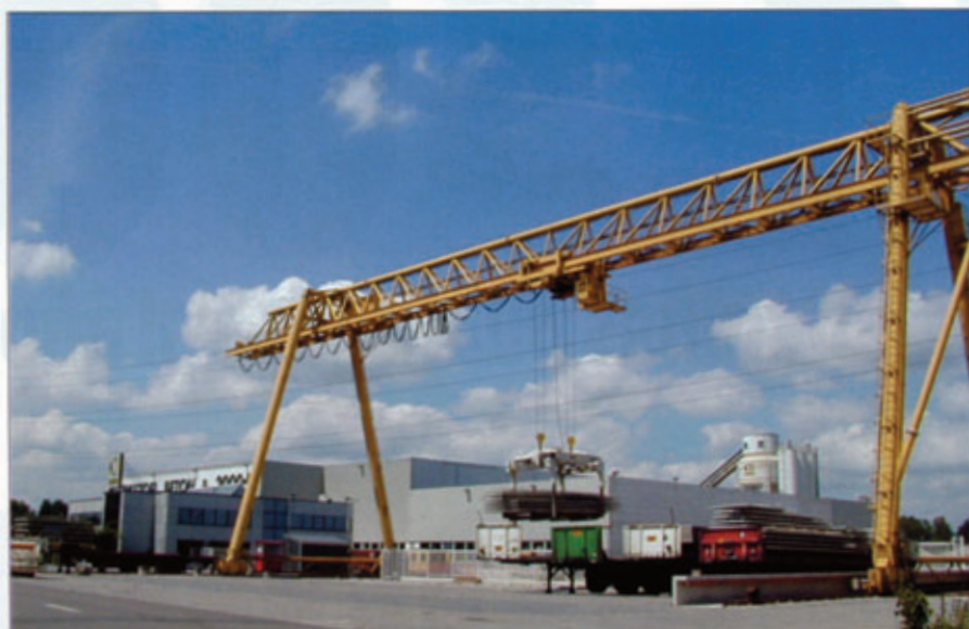
Estación de traslado de placas desde el carro de retirada a la grúa portal
