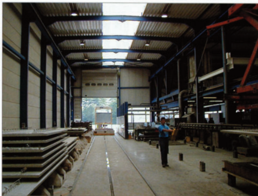
El área de desencofrado antes de la renovación
