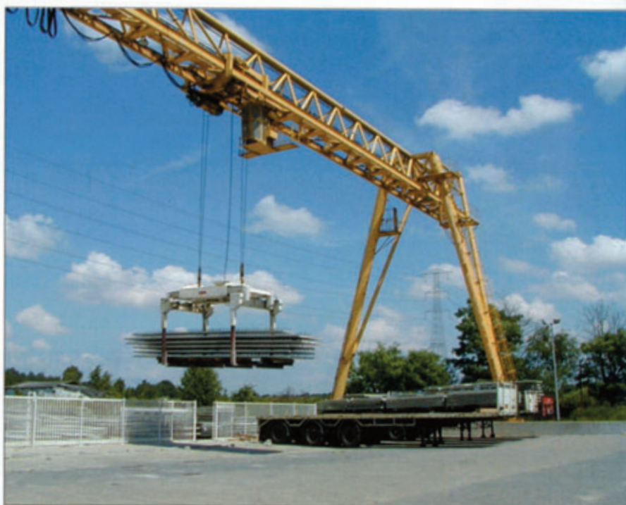
La grúa portal cargando una pila de placas
