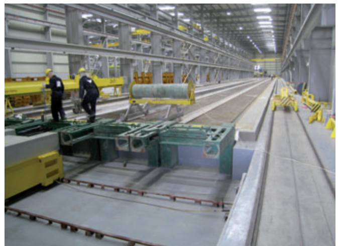
Instalación de producción para placas alveolares pretensadas
