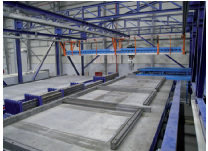
Robot de encofrado
