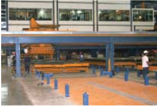
Fig. 12 Concreting with the concrete spreader. Abb. 12 Der Betoneinbau mit dem Betonverteiler.
