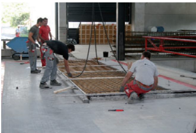
Colocación de la armadura en la siguiente estación
