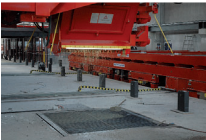
Estación de limpieza integrada directamente al lado de la estación de hormigonado
