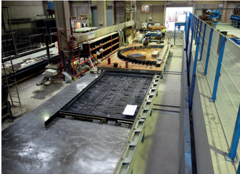
Abb. 5: Schalungs- und Bewehrungsstationen für Massiv-/Sandwichwand und Sondereile
