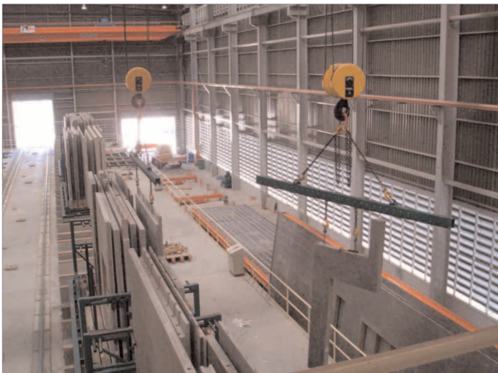
Zona de desencofrado
