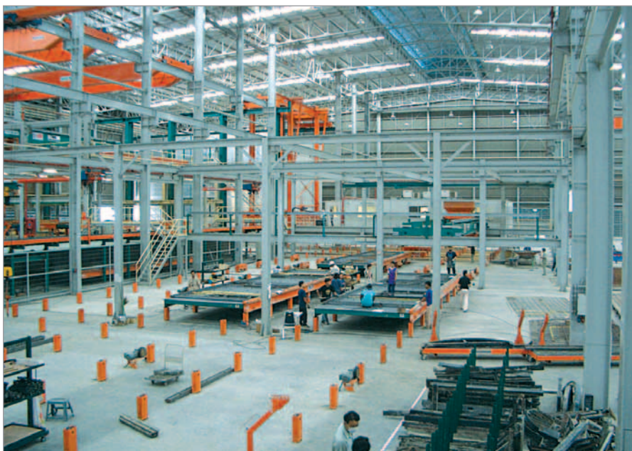
La zona para los trabajos de acabado de los encofrados
