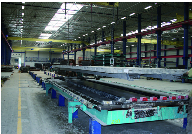
Распалубка ребристого перекрытия
