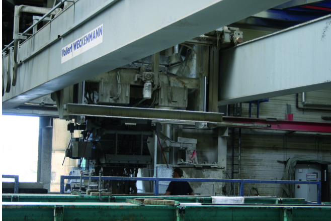
Бетонораздатчик обеспечивает весь процесс производства в первом цеховом пролете
