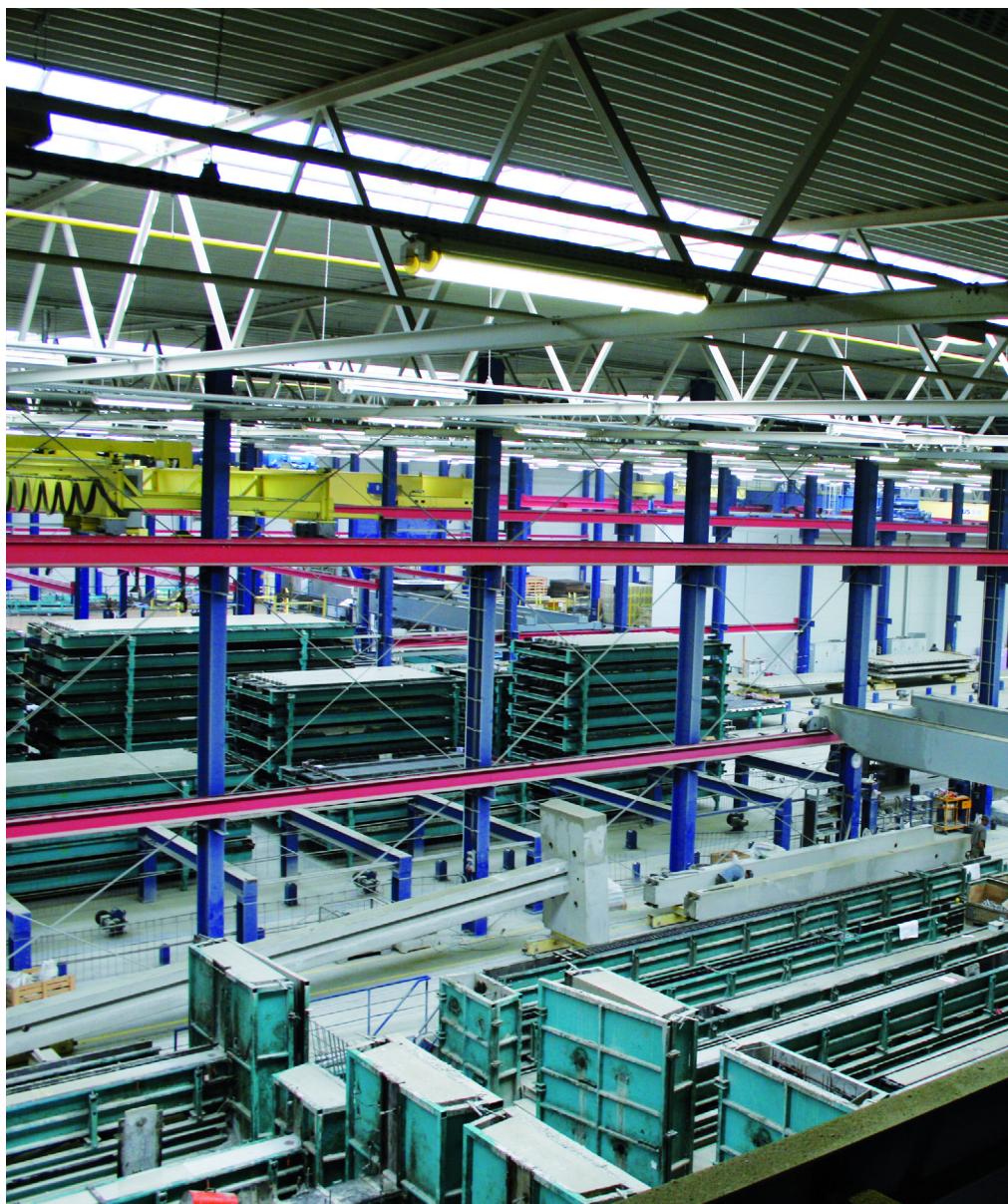
Вид «старой» части цеха 2009 года, где производились опоры и ребристые перекрытия
