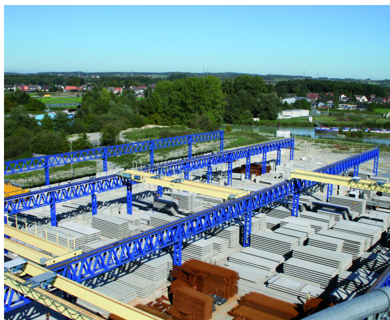
Вид с площадки цементного силоса: склад для ребристых плит перекрытия и опор
