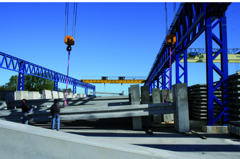
Сборные железобетонные опоры при погрузке
