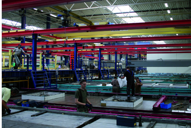
Рабочие станции производства стеновых панелей оснащены собственной крановой линией
