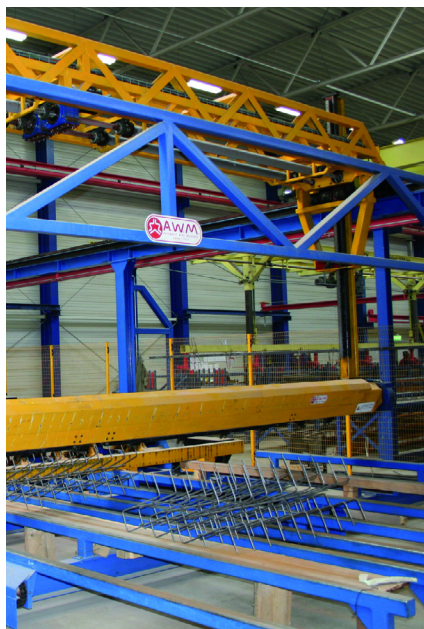
Изготовление арматурных каркасов
