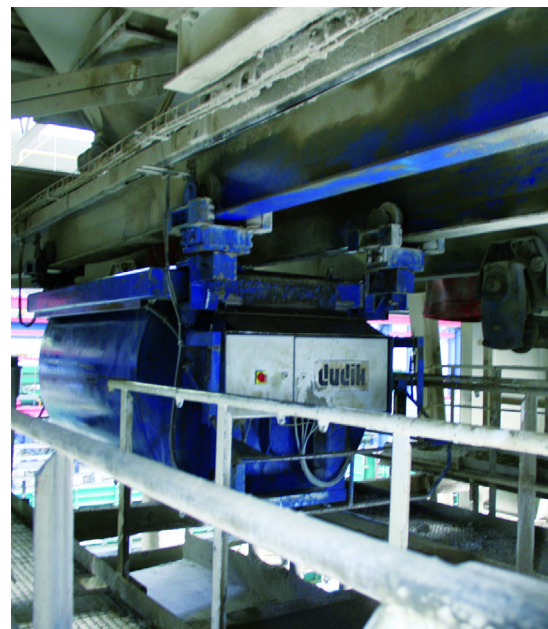
Бетон подается по кубельной линии раздачи
