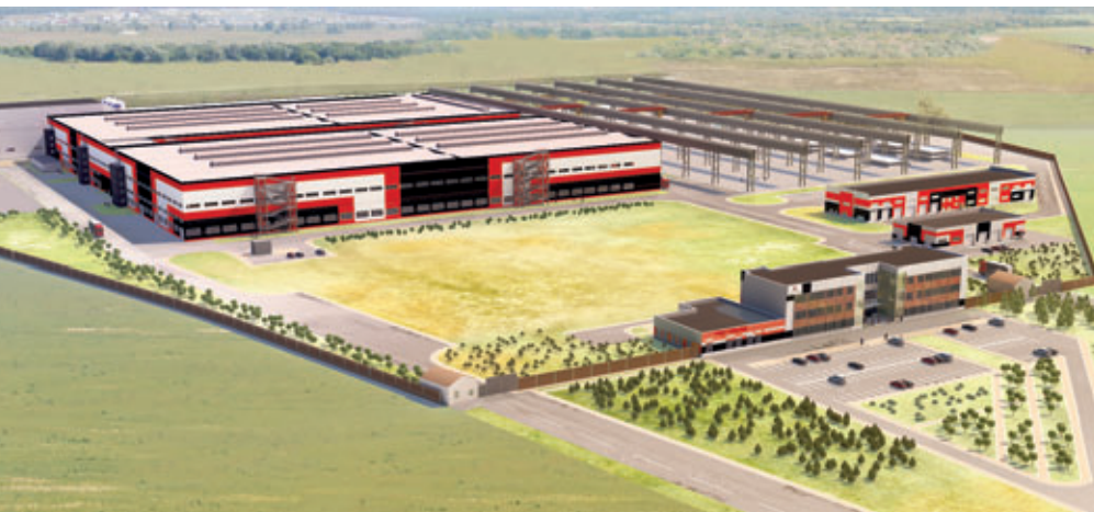
La capacidad de la fábrica de elementos prefabricados «DSK GRAD» será de 500 000 metros cuadrados de superficie habitable por año
