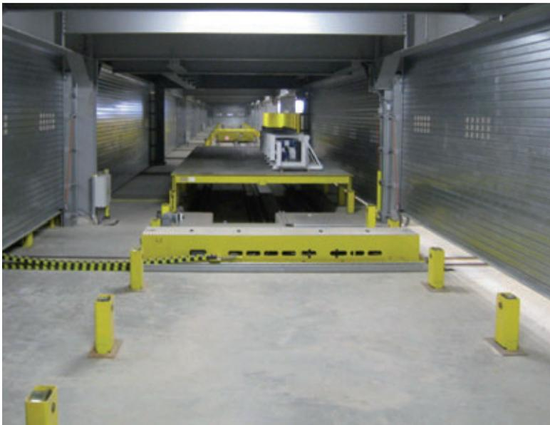
Рис. 18. Поддон и центральная транспортировочная тележка в туннеле
