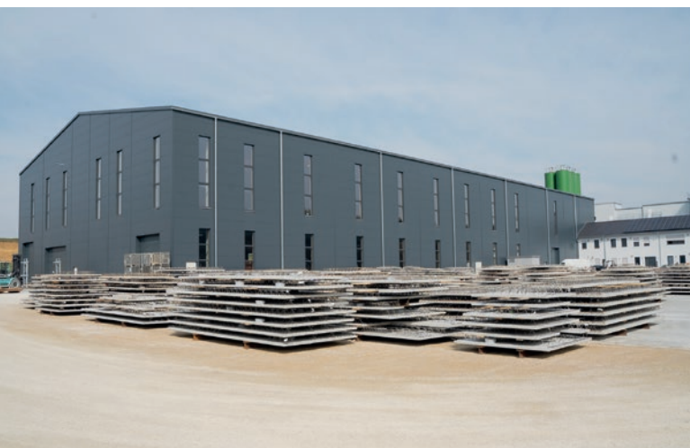
Am neuen Betriebsstandort von Wöhrl werden mit einer modernen Palettenumlaufanlage Elementdecken und Doppelwände hergestellt, Thermo- und Massiwände folgen.
