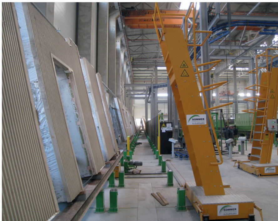
Транспортировка элементов в зону отделки
