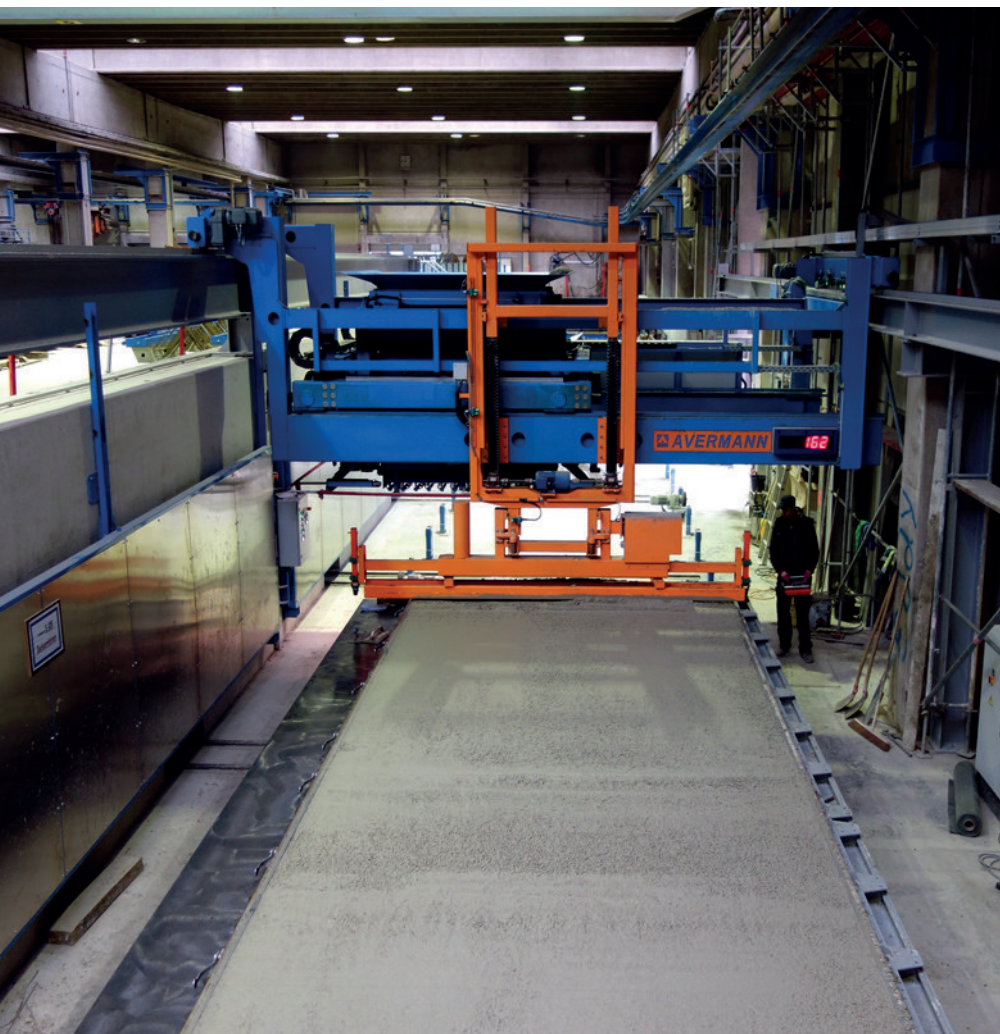
Крановый бетонораздатчик с заглаживающим устройством
