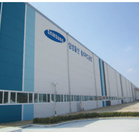
Фасады из сборного железобетона
