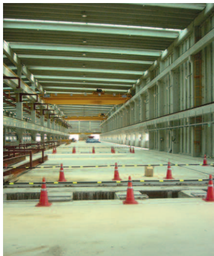
Новое помещение цеха для производства пустотных панелей на заводе №2
